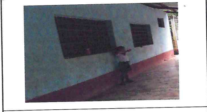
Foto 2: PINTURA EN MUROS EXTERIORES E INTERIORES
