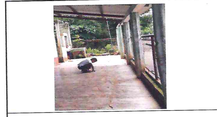
Foto 6: SUSTITUCION DE PISO CERAMICO
