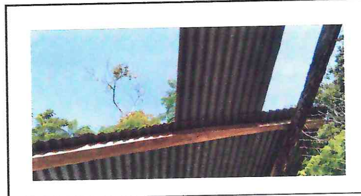
Foto 4: SUSTITUCION DE ESTRUCTURA DE SOPORTE POR METAL
