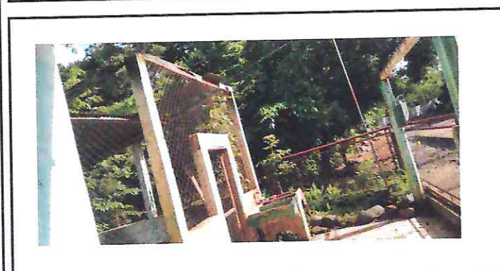
Foto 3: SUSTITUCION DE LAMINA, POR LAMINA TROQUELADA
