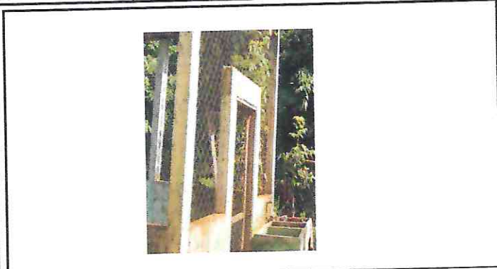
Foto1: SUSTITUCION DE PUERTA
